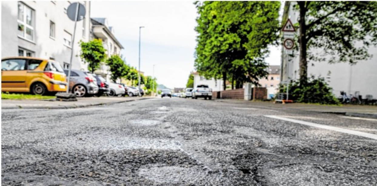
Die Rheinstraße kann zwischen Mosel- und Fabrikstraße saniert werden. Die Stadtverordnetenversammlung stimmte dem Vorhaben nun zu.
